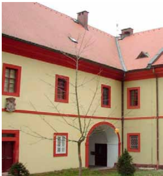
Jilemnice, č. p. 1, stav před a po rekonstrukci
