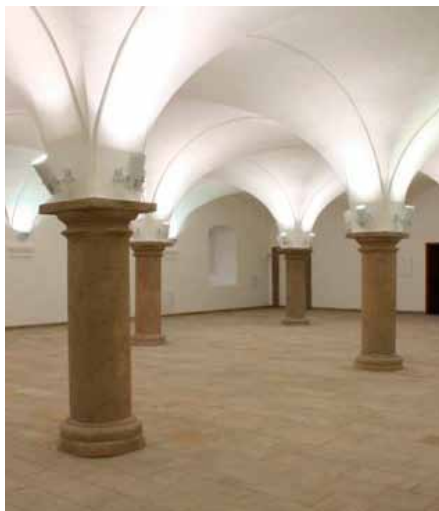
Sloupová síň před a po rekonstrukci, č. p. 1, Jilemnice
