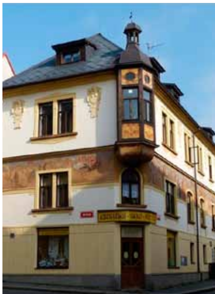
Masarykovo náměstí č. p. 6, Jilemnice původní stav a stav po rekonstrukci
