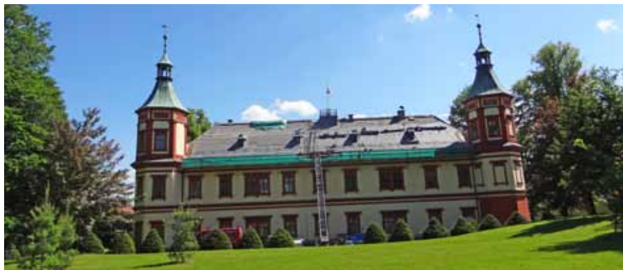
Jilemnický zámek, oprava střechy
