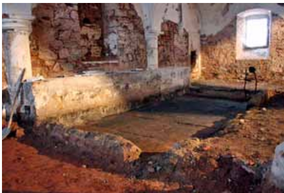
Bývalý pivovar Jilemnice, stavebně-historický průzkum
